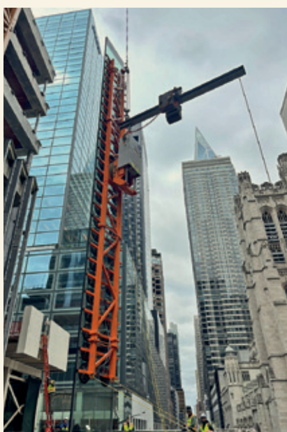
Montaggio Vetrate - Grattaciolo a New York 5ta-6ta Avenue
