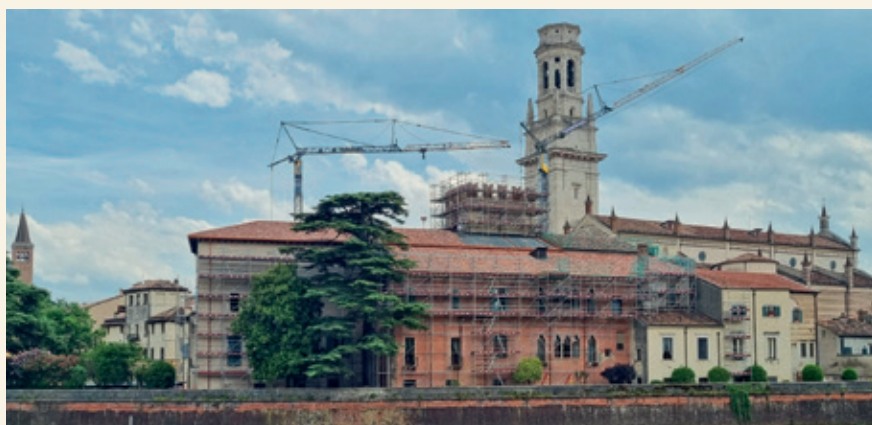
Adeguamento sismico della torre e del Palazzo Vescovile in centro storico a Verona, appena completato
