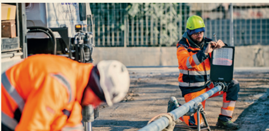
Fase di installazione di corpi illuminanti
