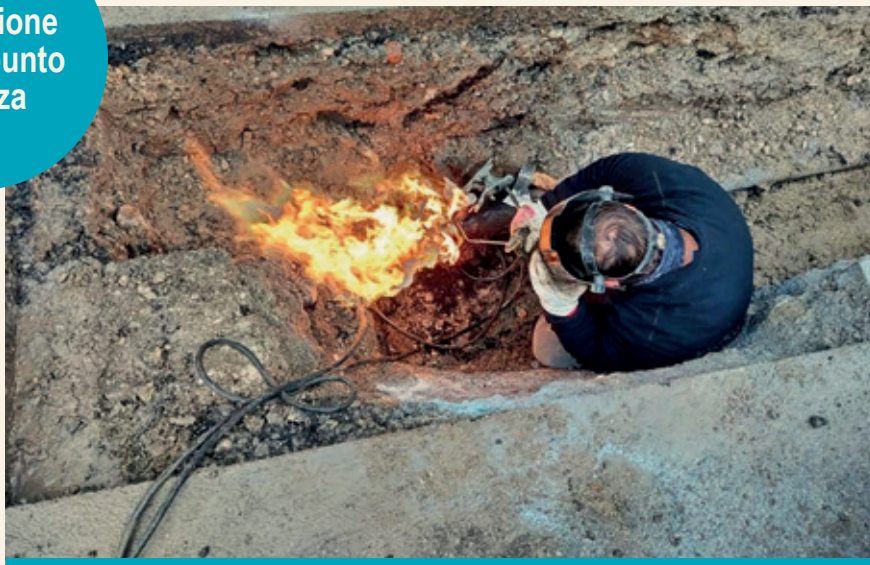
Riparazione perdita gas
